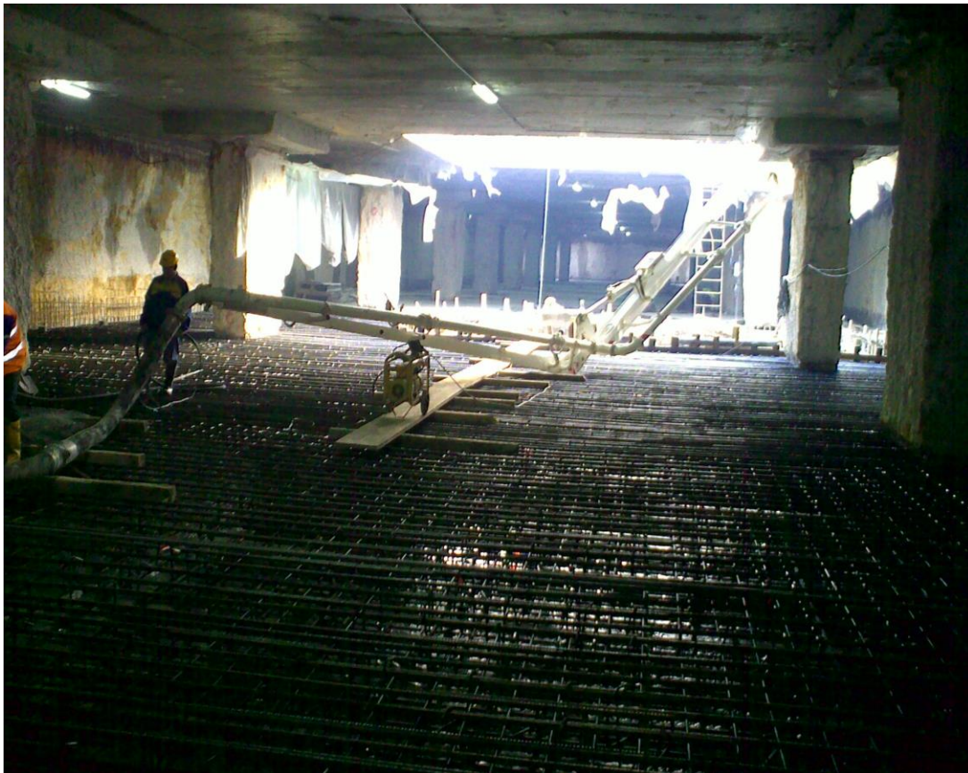
Фиг. 3 Изграждане на метростанция по „Милански метод“
